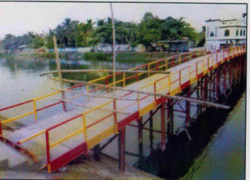
৭নং ওয়ার্ডে কদমতলী উত্তর পাড়া মেকার মসজিদ হতে আদমজী ইপিজেড বরাবর আর এস জয়েন্ট ও আরসিসি শ্রাব ঘারা ফুট ওয়ার ব্রিজ নির্মাণ
