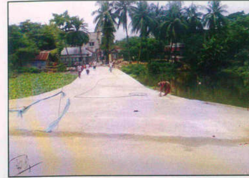
২৪নং ওয়ার্ডে মদনগঞ্জ-মদনপুর সড়ক হতে লুইয়া ব্রিজ পর্যন্ত ড্রেনসহ রাস্তা নির্মাণ।
